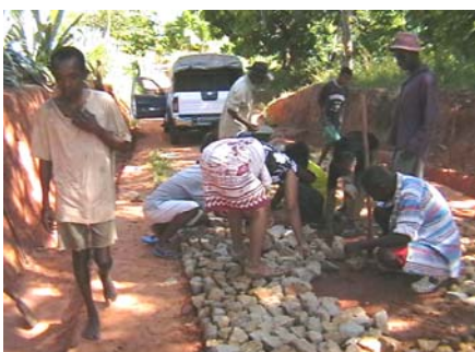
Formation pratique en entretien de route : pose de cloutage
