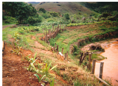
Travaux de protection biologique de la piste (Après)
